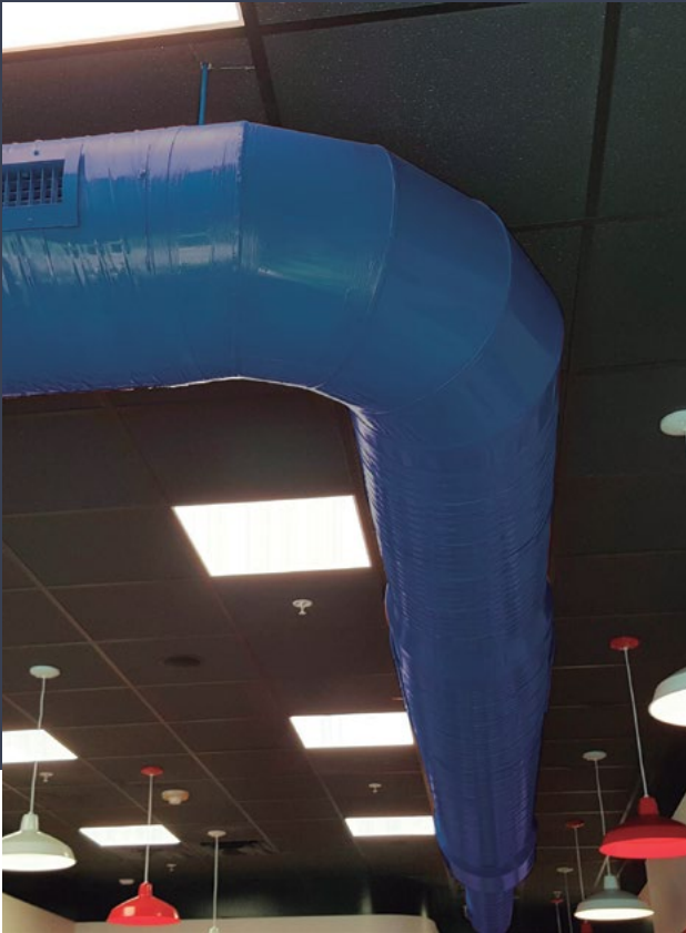
TRATAMIENTO QUÍMICO PARA LA APLICACIÓN DE PINTURA.
